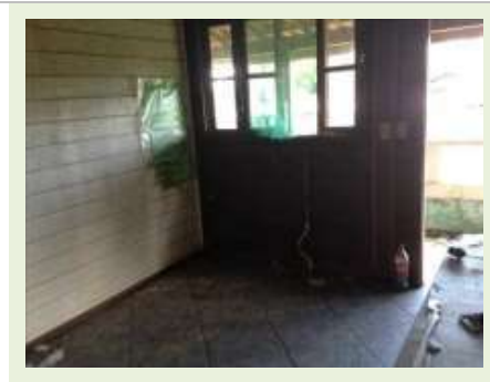
Vista Parcial - Casa 02
