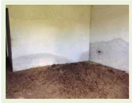
Vista Parcial - Casa 02
