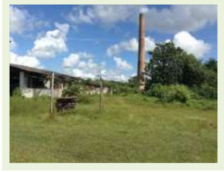
Vista da Área
