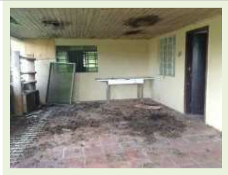
Vista Parcial - Casa 01
