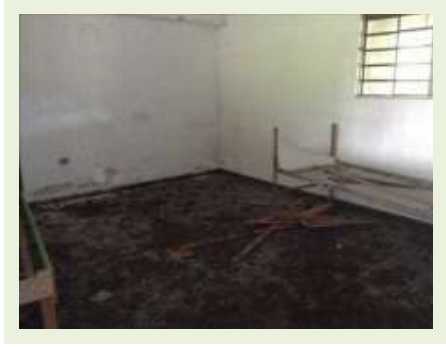
Vista Parcial - Casa 01
