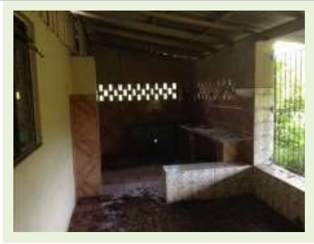
Vista Parcial - Casa 01
