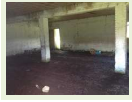
Vista Parcial - Casa 02
