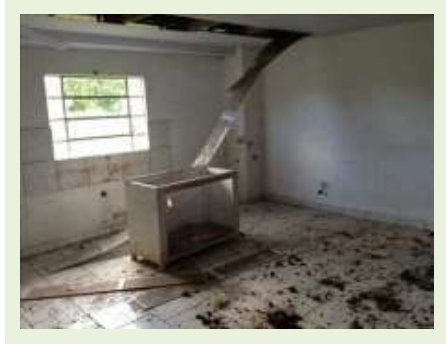
Vista Parcial - Casa 01
