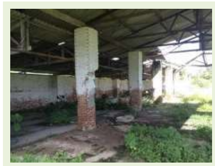
Vista Parcial - Cobertura
