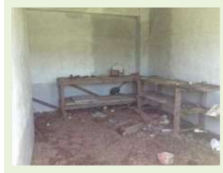
Vista Parcial - Casa 02
