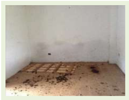
Vista Parcial - Casa 01
