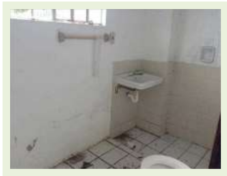
Vista Parcial - Casa 01
