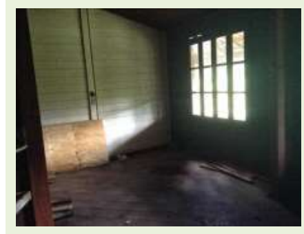
Vista Parcial - Casa 02
