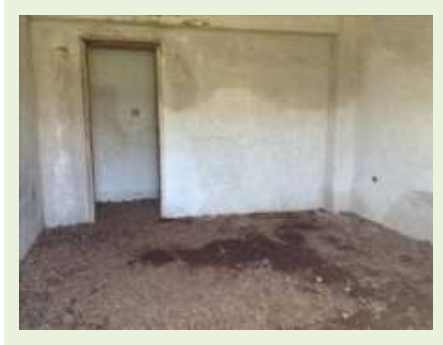
Vista Parcial - Casa 02
