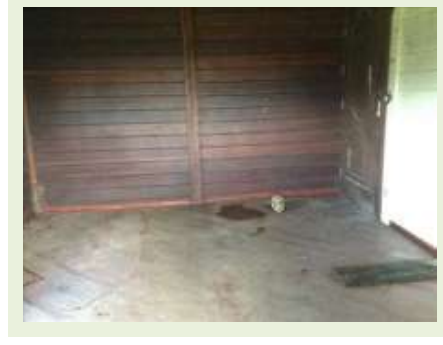
Vista Parcial - Casa 02
