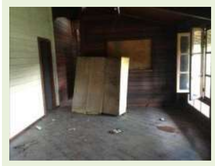
Vista Parcial - Casa 02
