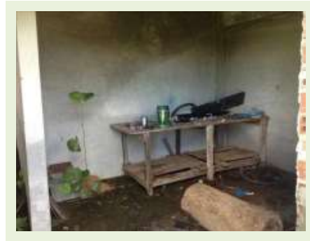
Vista Parcial - Casa 02
