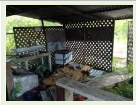
Vista Parcial - Casa 02
