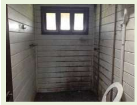
Vista Parcial - Casa 02
