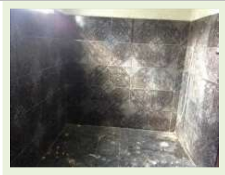
Vista Parcial - Casa 01
