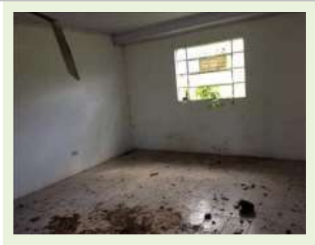
Vista Parcial - Casa 01
