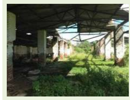
Vista Parcial - Cobertura
